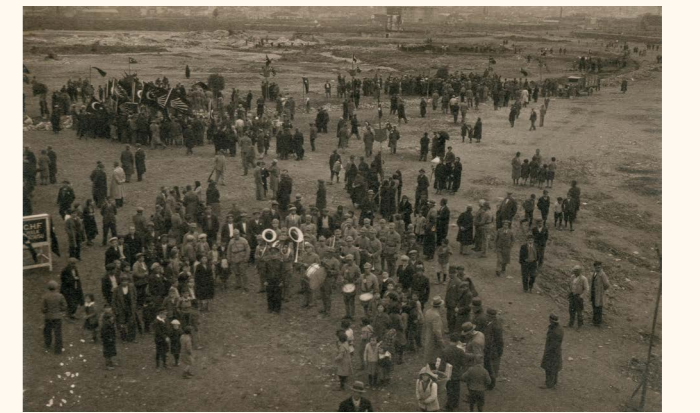
1936 Yılı İzmir Enternasyonal Fuarı temel atma töreni. (www.facebook.com, "Küllerinden Doğan Şehir İzmir", 26.02.2024).
